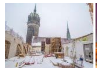
Baustellenführung im Wittenberger Schloss
